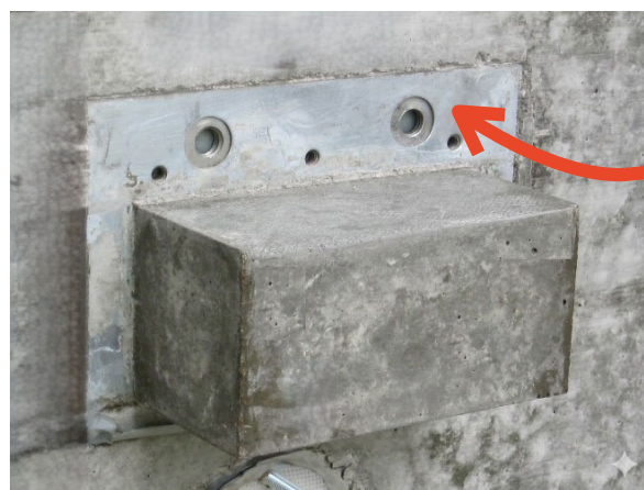
ボス型枠の脱型
