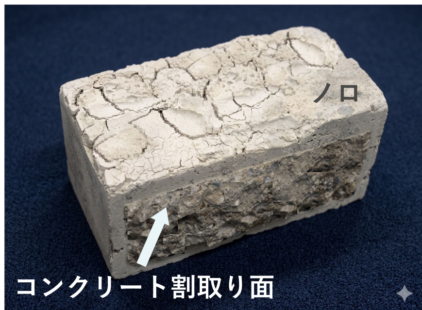
ボス供試体上面に生じた脆弱な層
