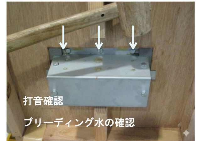
充填状況の確認
