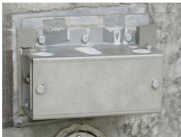
ボス型枠の脱型
